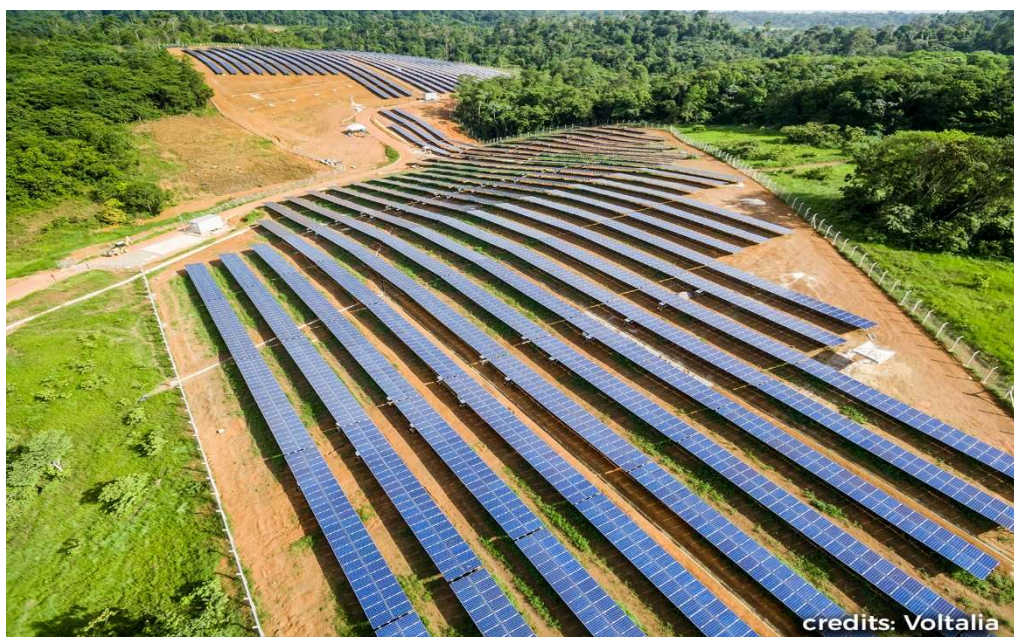
Centrale solaire pour l'électrification rurale à Oiapoque, Brésil
